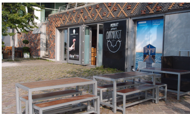
Sealable building, Hafencity Hamburg (D)
